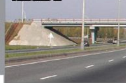
Автодорога Казань - Оренбург на участке км 8 - км 20 с подъездом к аэропорту "Казань-2"
