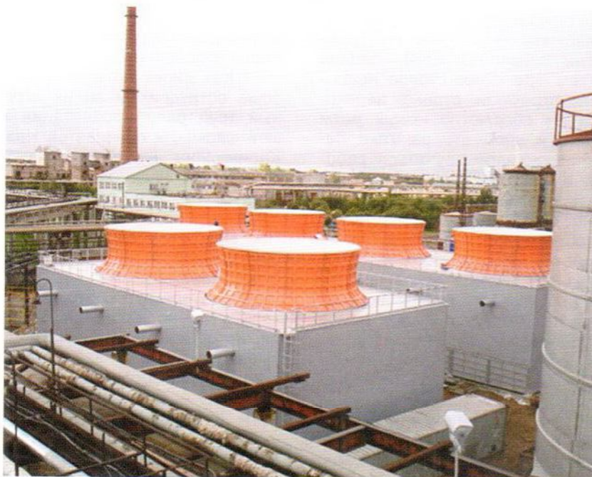
ОАО «Монди Бизнес Пейпа Сыктывкарский ЛПК». Замена башенной градирни на 5 секций БМГ-2000х5. Резко сокращено энерго- и водопотребление.
