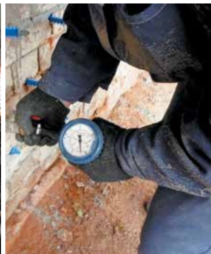
▲ Инъектирование кирпичной кладки, госпиталь, г. Казань, ул. Карла Маркса, д. 76
