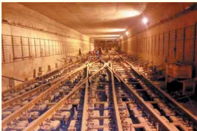
ООО «Горно-строительная компания – подземные технологии» (г. Казань, руководитель Криницын Владимир Борисович), объект строительства «Станция метро «Лухмановская» в г. Москва, РФ»
