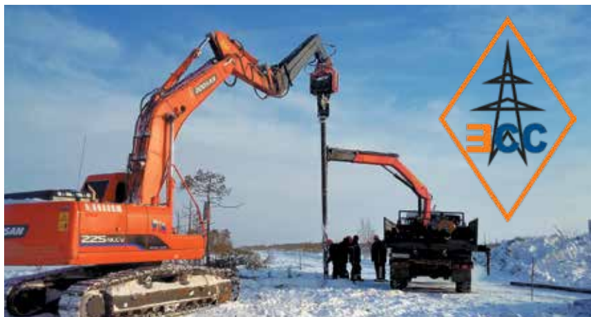
▲ Строительство ВЛ-6 кВ для ТПП «Покачевнефтегаз»
