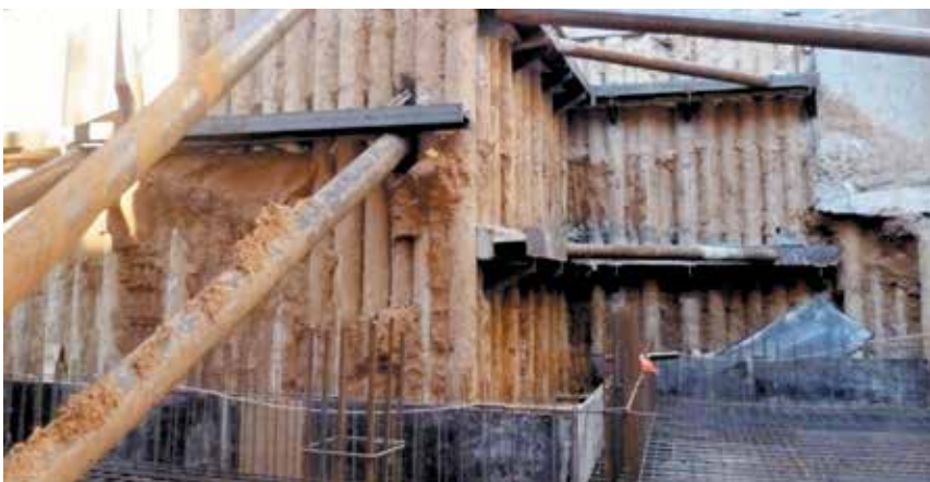
▲ Буронабивные сваи, г. Казань, ул. Пушкина, д. 10
