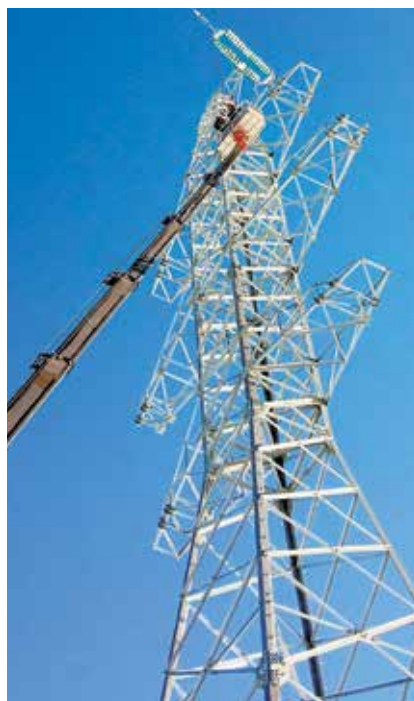
▲ Подвеска провода на КВЛ-220 кВ «Щелоков – Центральная»
