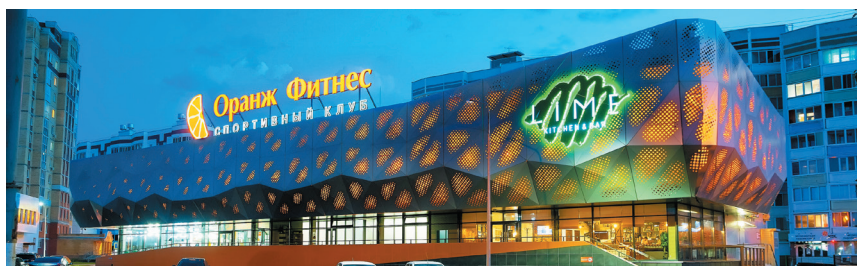
📍 «Оранжевый Фитнес». Монтаж навесного параметрического перфорированного фасада, витражей, внутренних перегородок
