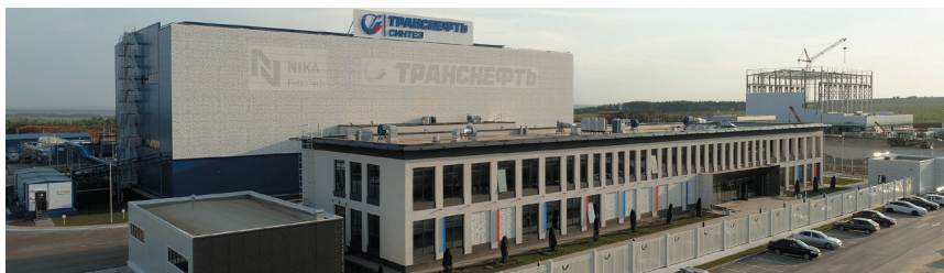
📍 «Транснефть-Синтез». Монтаж перфорированного фасада, алюминиевых витражей, внутренних перегородок
