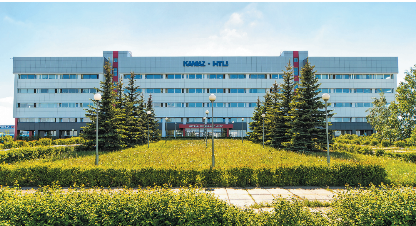
📍 НТЦ «КАМАЗ». Монтаж навесного вентилируемого фасада, окон, алюминиевых витражей
