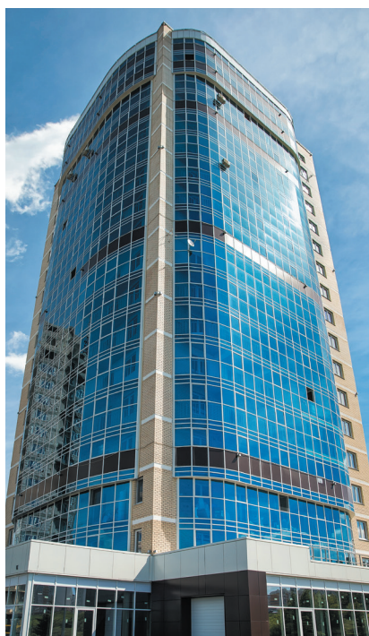
📍 ЖК «ПАРУС». Монтаж навесных балконных витражей
