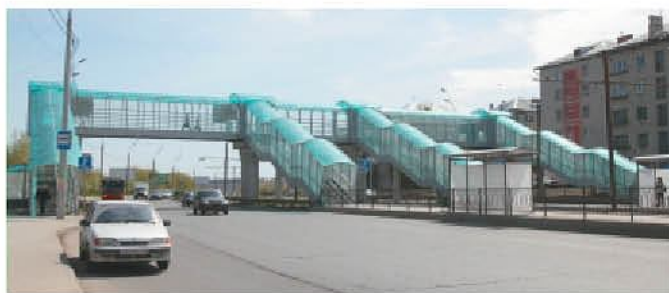
Действующий надземный пешеходный переход в районе торгового дома «Риф-Эль» по ул. Академика Арбузова
