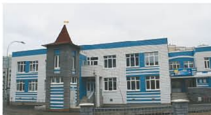
Название: «Аистенок» Мест: 260 Подрядчик: «Восток С» Адрес: ул. Ак. Глушко, 29
