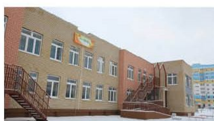
Название: «Кучтәнэч» Мест: 260 Подрядчик: ООО «Камаглавстрой» Адрес: ул. Ак. Глушко, 22д
