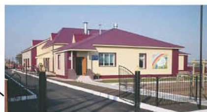
Название: «Бэлэкэч» Мест: 30 Подрядчик: ООО «Актанышские инженерные сети» Адрес: н.п. Меннярово
