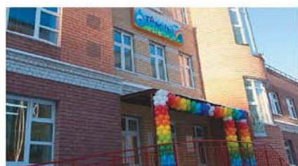
Название: «Тамчы» Мест: 120 Подрядчик: ООО «МСУ-Строй» Адрес: ул. Ак. Сахарова, 12а
