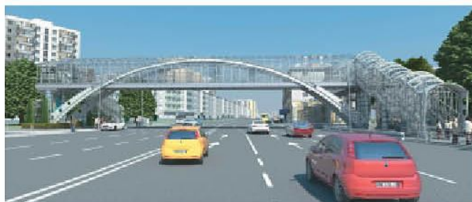
Строящийся надземный пешеходный переход на пересечении улиц Павлюхина и Халева
