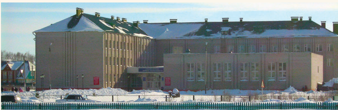
Школа с бассейном в Муслюмове (открыта в 2003 году). Проектировщик — АО «Казанский Гипрониавиапром»
