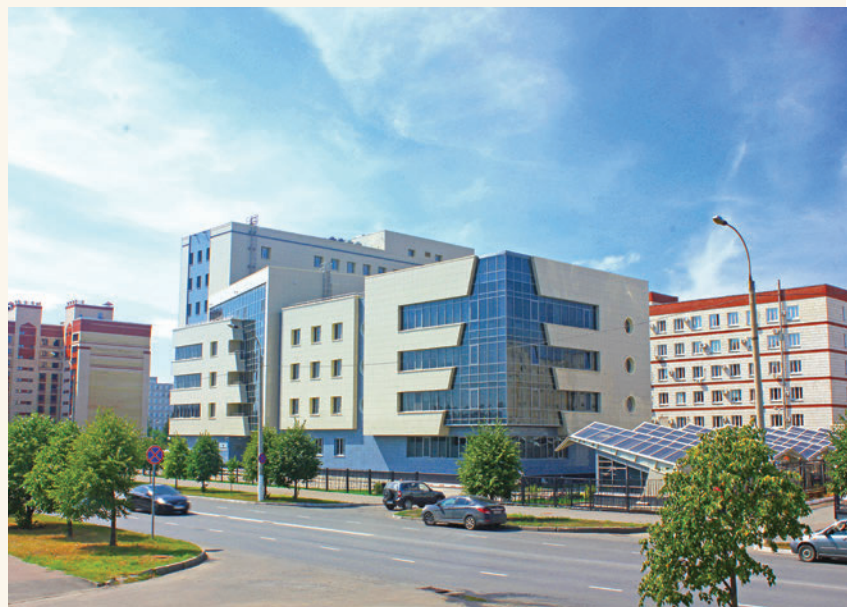
Реконструкция комплекса ОАО «Сетевая компания»
