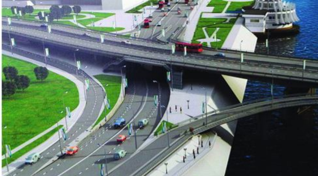
Геодезическое сопровождение реконструкции существующего участка Ленинской дамбы и моста через р. Казанку.
