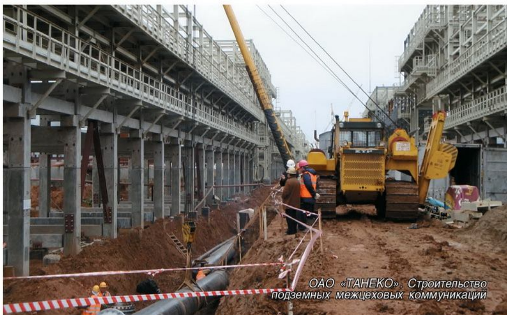
ОАО «ТАНЕКО». Титул 027 РВС 50 000 м³
