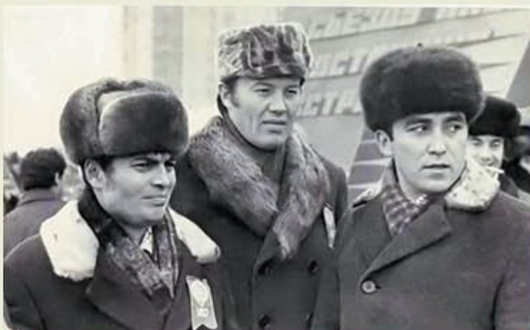
На строительстве КамАЗа.
