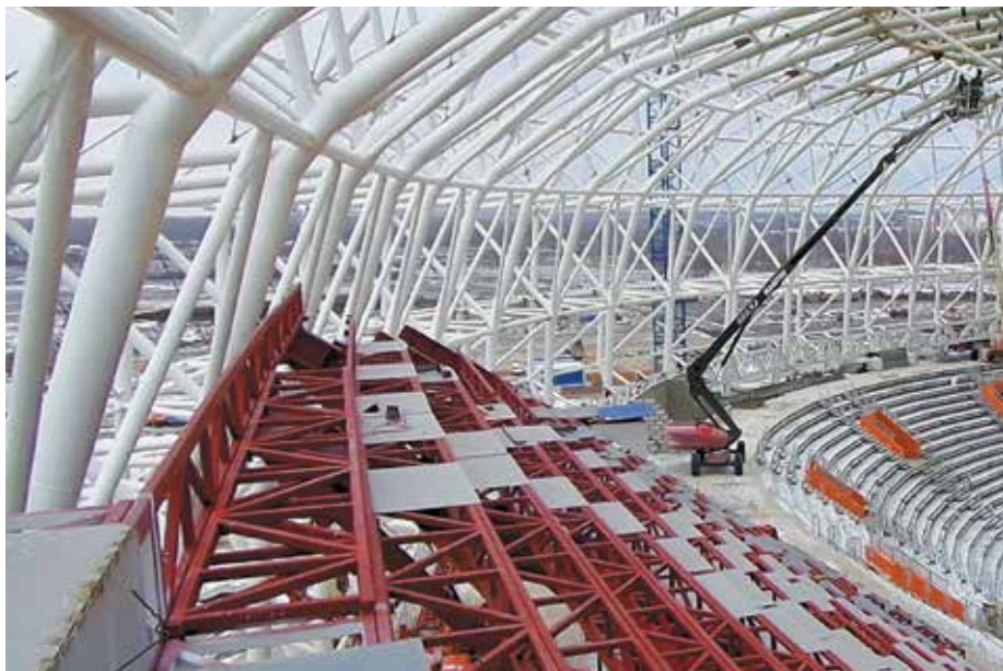
▲ Трибуны для строящегося к чемпионату мира по футболу 2018 года стадиона «Мордовия-Арена» в Саранске
