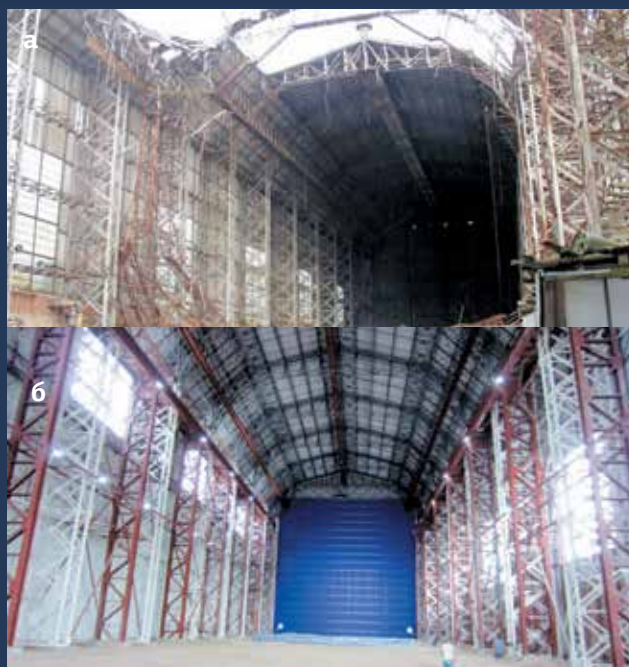
▲ Рис. 1. Реконструкция лабораторно-испытательного корпуса (эллинга), г. Долгопрудный: а – до реконструкции; б – после реконструкции
