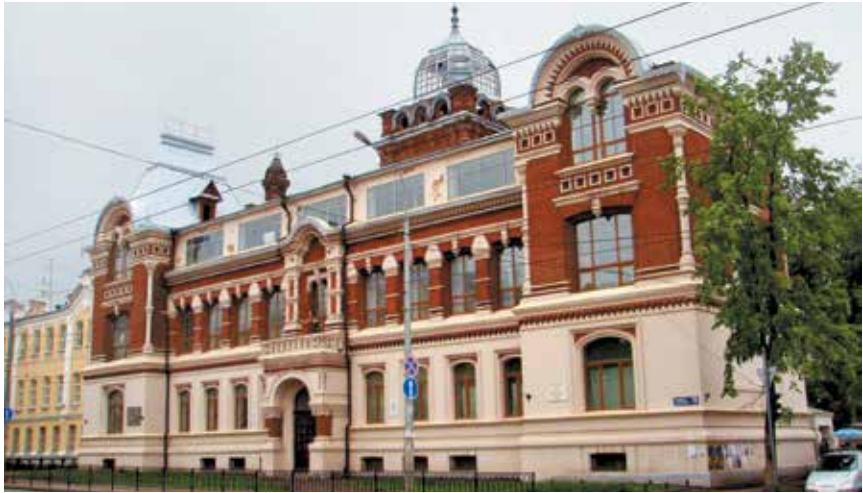
▲ Здание Казанского художественного училища им. Н.И. Фешина – объект культурного наследия федерального значения. Крыша украшена стеклянным шлемовидным куполом, который увенчал здание после пожара в начале XX века.
