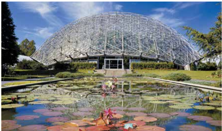
▲ Ботанический сад Миссури. Геодезический купол – одно из практических применений фуллеровской геометрии, основанной на векторном разбиении пространства. Основная единица такого деления – тетраэдр, грани которого располагаются на геодезических линиях (кратчайшие линии, соединяющие две точки на криволинейной поверхности). Такое разбиение позволяет добиться оптимального заполнения пространства и наиболее полного использования структурной прочности материалов. Таким образом геодезический купол покрывает максимально возможное пространство с использованием наименьшего количества строительных материалов. И чем больше купол, тем, пропорционально к изменению его размера, легче и прочнее его конструкция.
