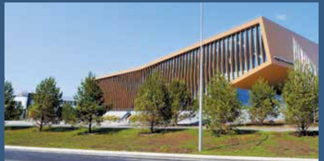
▲ г. Иннополис, вантовая 12- метровая консольная часть учебно-лабораторного корпуса университета с аудиториями
