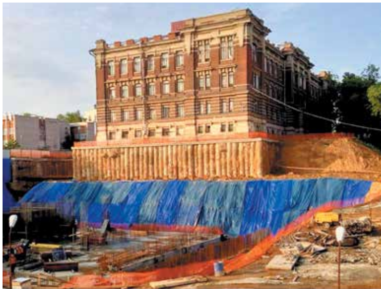
▲ Реконструкция фундамента Шамовской больницы
