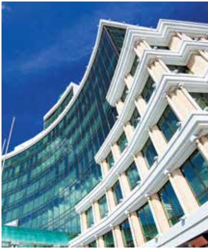
▲ Фасад административного здания Пенсионного фонда РФ по РТ. Площадь остекления здания – около 3000 м 2 .
