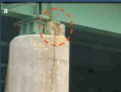
▲ Рис. 2. Современная методика расчета оголовков железобетонных колонн по образованию и раскрытию трещин: а – повреждения, выявленные при обследовании; б – повреждения, отмеченные в литературе; в – расчетная схема
