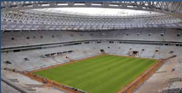
▲ Вид на новые конструкции трибун БСА «Лужники» после реконструкции по проекту АО «Казанский Гипрониавиапром»
