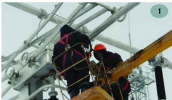
Строительство ПС 500 кВ «Елабуга». Монтаж ячеек на РУ 500 кВ
