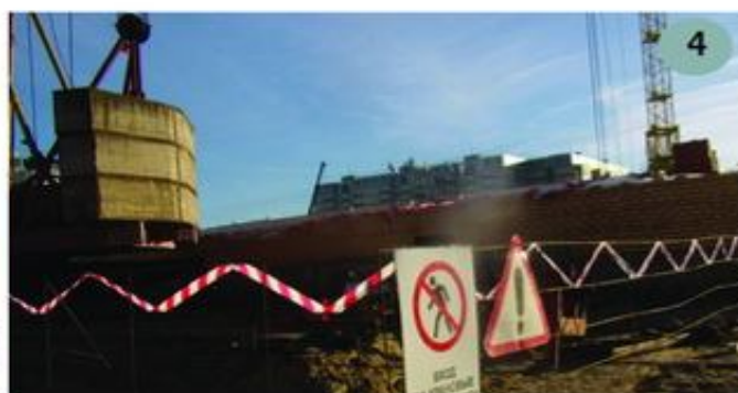
Строительство 3-этажного здания школы № 57-33 на 1000 учащихся в м/р № 57 Ново-Савинов- ского района в г. Казани
