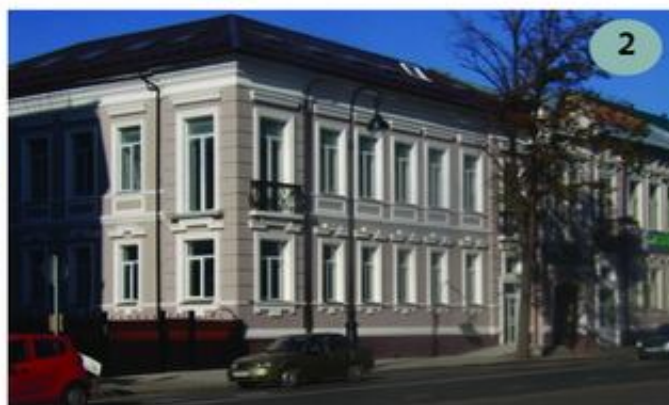
3-этажное новое здание д.8 по ул. Островского в г. Казани
