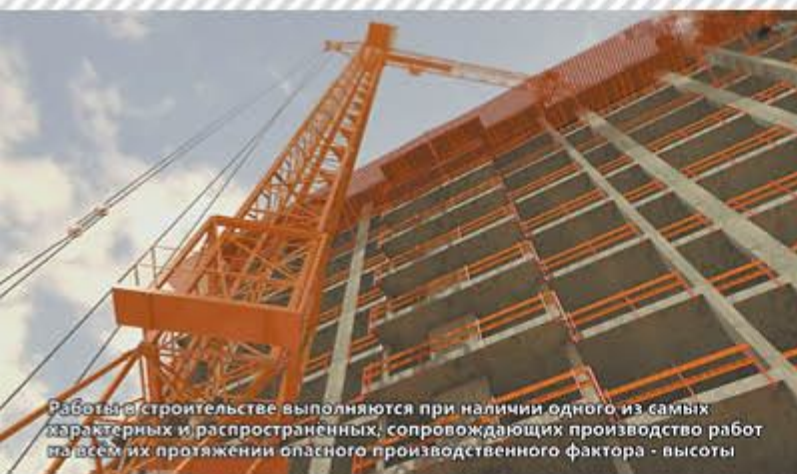
Расстояние между горизонтальными элементами в вертикальной плоскости защитного ограждения должно быть не более 0,45м
