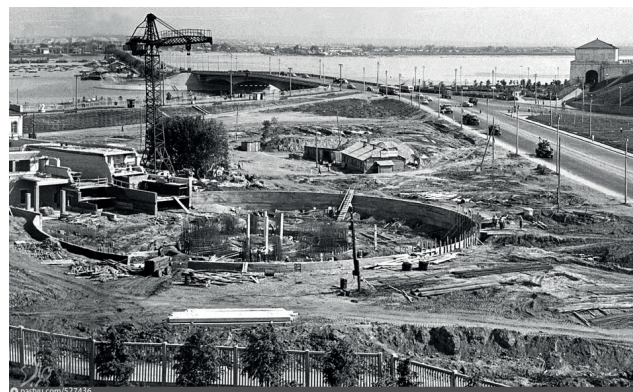
Строительство Казанского цирка, 1960-е гг.
