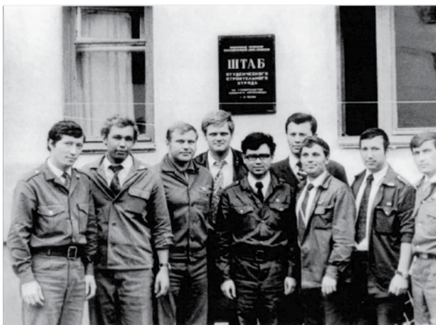
▲ Штаб студенческого строительного отряда г. Набережные Челны, 1974 г.
