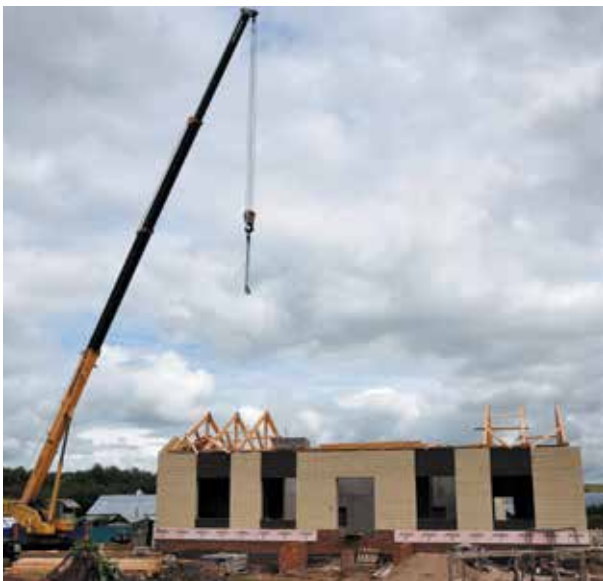
▲ Строительство МФЦ в селе Коморгузя, Атинский район
