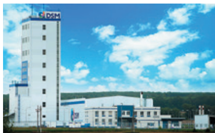
Завод по производству комбикормов (г. Набережные Челны)
