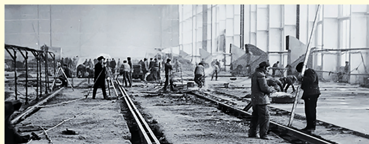
▲ Строительство корпусов КАПО им. Горбунова
