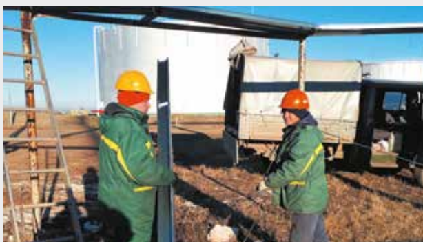
ООО «Катодстрой», пгт Джалиль (руководитель – Талибуллин Салават Талгатович), выполняло функции подрядчика на объекте «Обустройство ГЗУ на объекте НГДУ «Джалильнефть», генподрядчик ООО «ПрикамНефтеСтройСервис»
