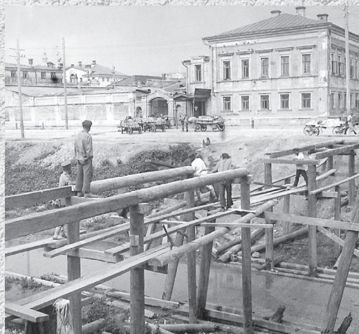
▲ Строительство моста через Булак, 1927 г.
