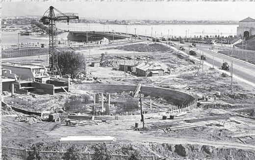
Строительство Казанского цирка, 1960-е гг.
