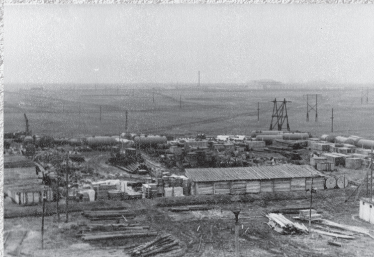
Начало строительства Казанского химического завода, 1959 г.
