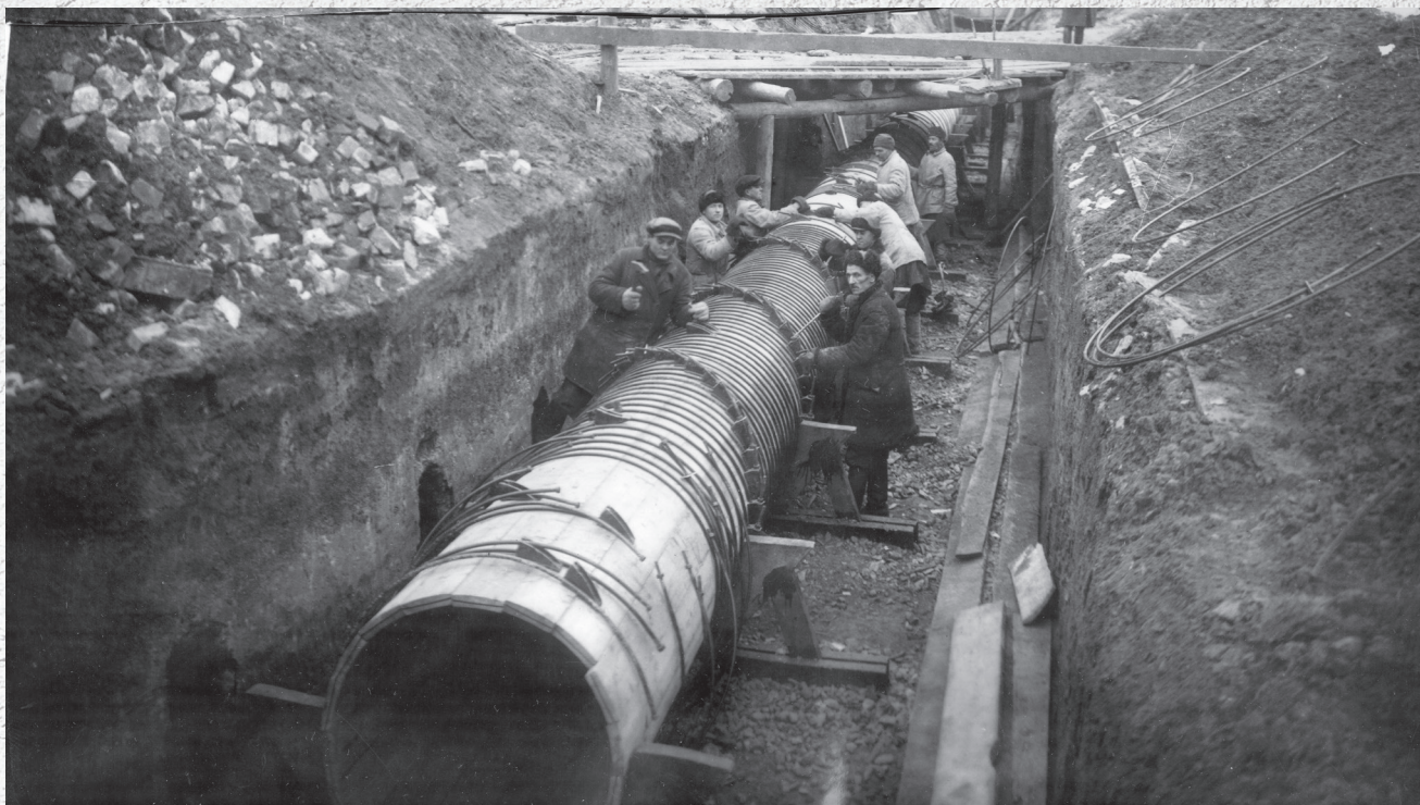
▲ Строительство деревянного циркуляционного водовода, г. Казань, 1930 г.
