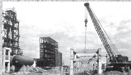
Строительство корпусов производства фенола-ацетона Казанского химического завода, 1961 г.
