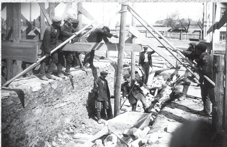
▲ На строительстве Казанской ТЭЦ-1, 1931 г.
