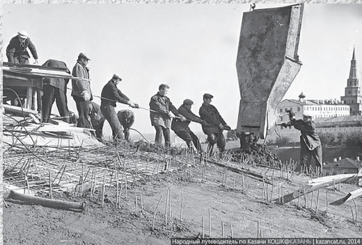
Строительство Казанского цирка, 1960-е гг.
