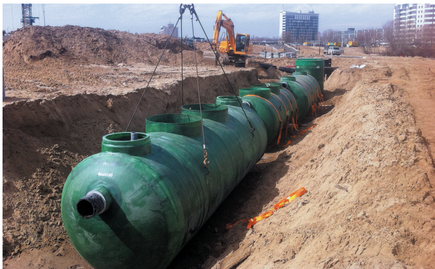
Монтаж емкостей ливневых очистных сооружений
