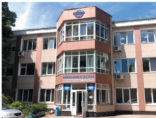
▲ Административно-бытовой корпус ПК «Нижнекамскгэсстрой»
