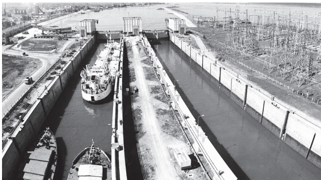
Шлюзы Нижнекамской ГЭС
