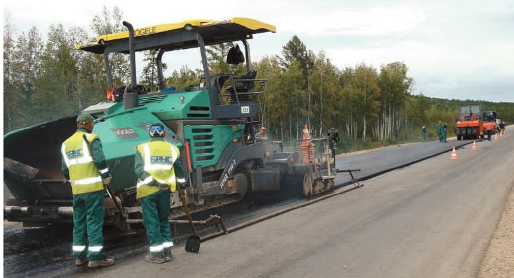
Укладка асфальто-бетонной смеси на автодороге «Амур», 2010г.
