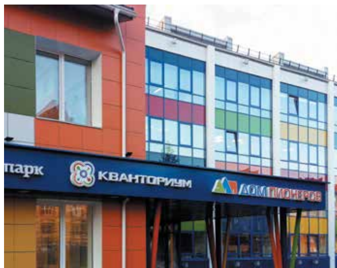
▲ Реконструкция здания, Центр детского творчества
