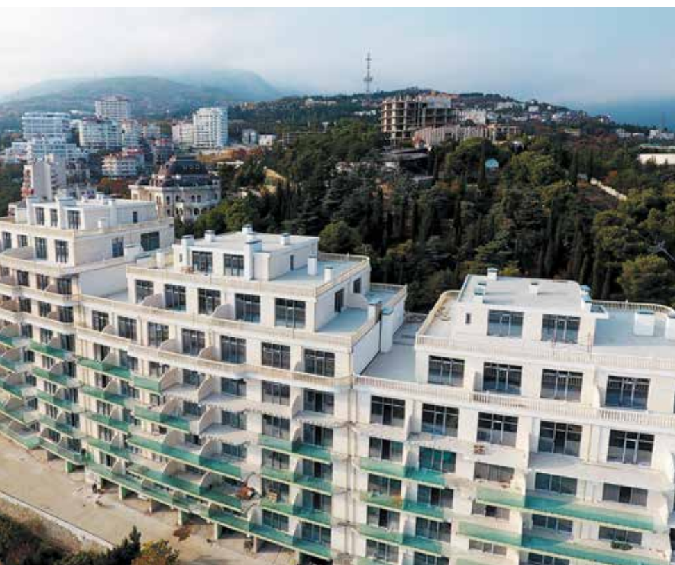
▲ Применение гидроизоляции PLASTFOIL® в ЖК «Холм Славы». Крым, г. Ялта, 2017 год
