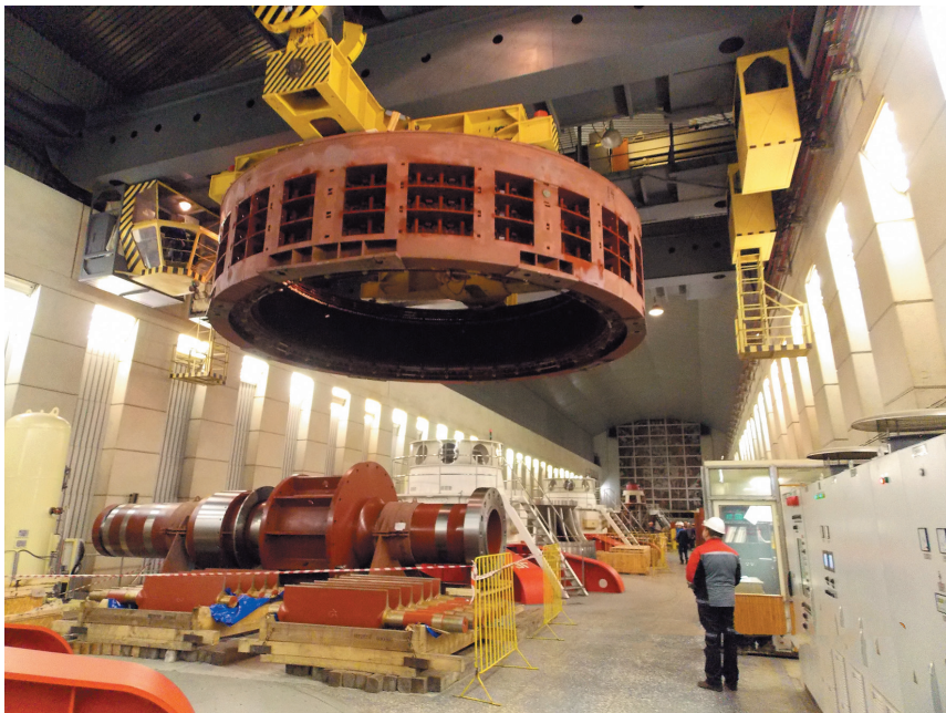
Ⓜ Перенос корпуса статора гидрогенератора
