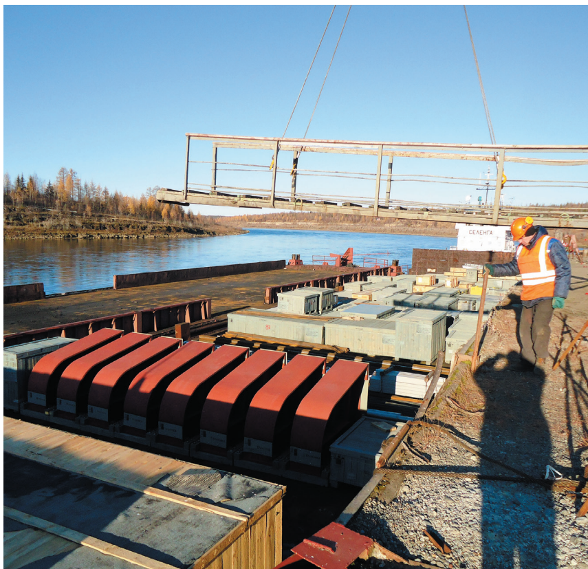
⦿ Выгрузка оборудования с барж на Причале № 5
