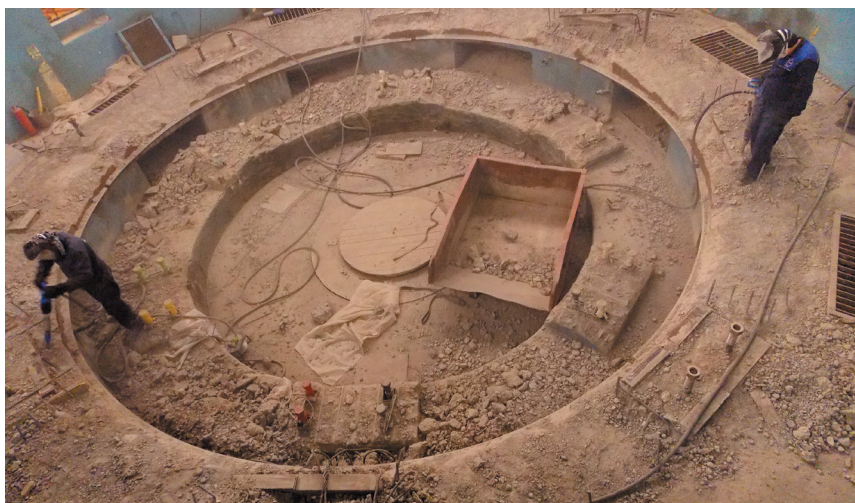
Гидроагрегат в процессе реконструкции
