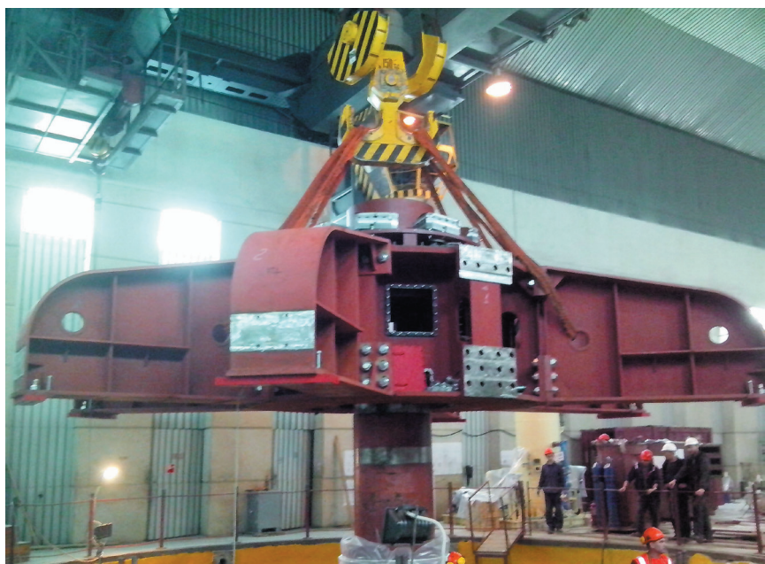
Ⓜ Монтаж верхней крестовины
