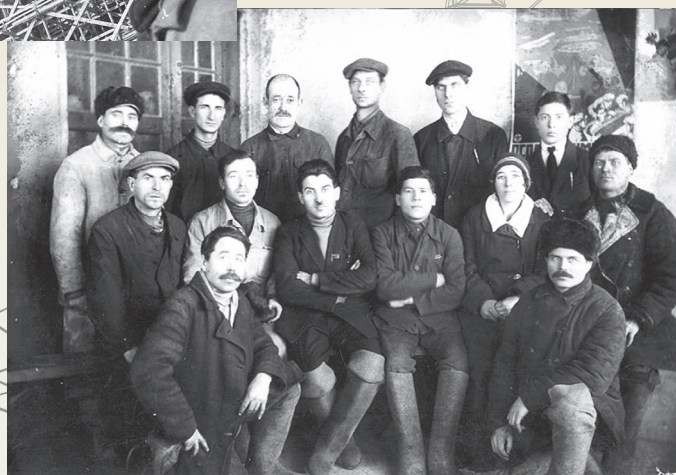
▲ Коллектив строителей и первых работников КТЭЦ-1
