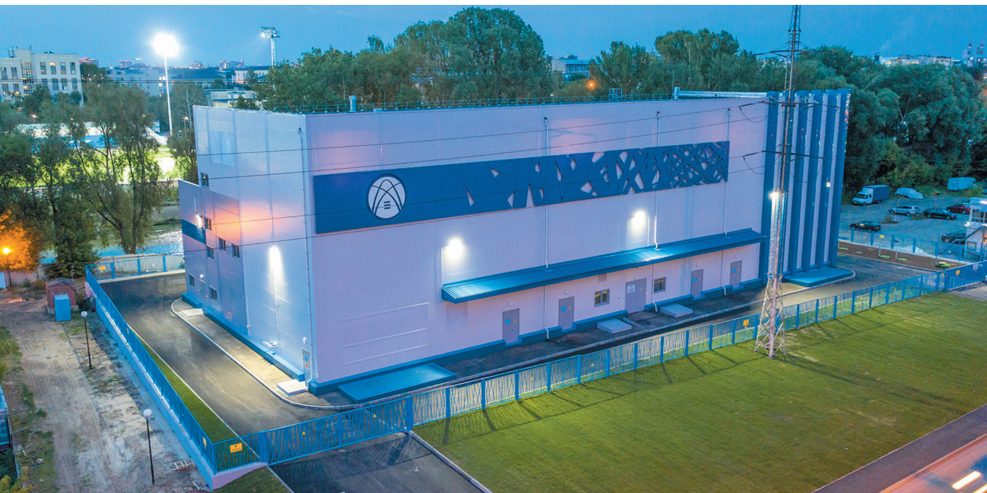
Первая в Татарстане цифровая подстанция ПС-110 кВ «Портовая»
