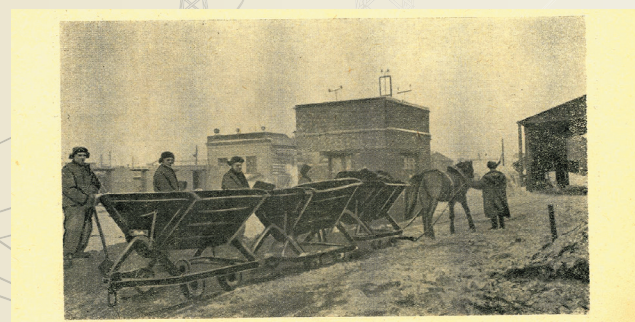
Подача угля в бункеры котельной Казанской ТЭЦ-1 в 1933 г.
