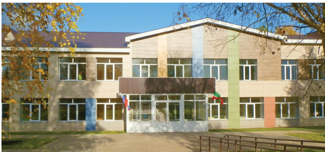
Н. Табынская коррекционная школа после капитального ремонта (подрядчик — ЗАО «Муслюмовская МСО», 2016 г.)
