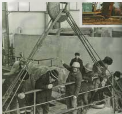
▲ Строительство производства ПНД
