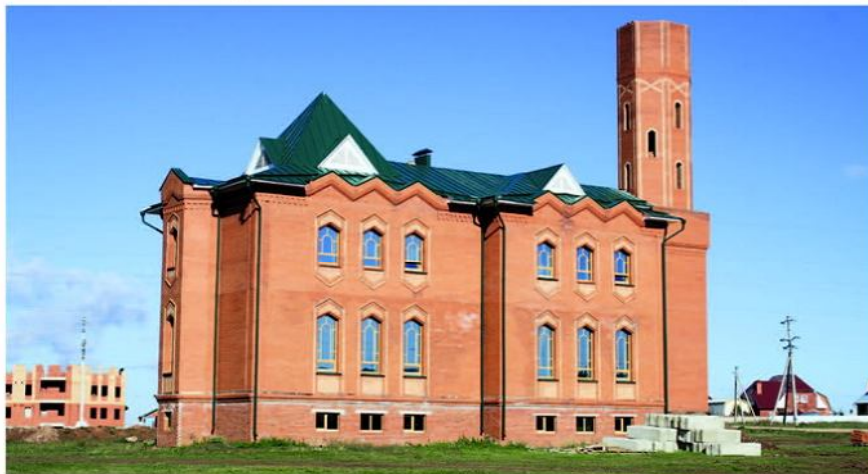
Строительство мечети «Западная» в г. Арске
