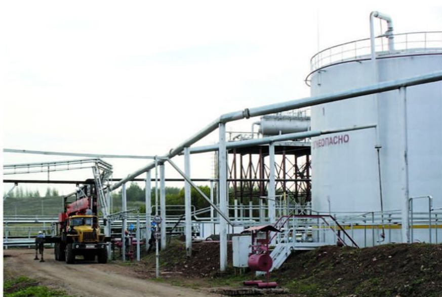
Строительство эстакады системы КИПиА на площадке резервуаров товарной нефти
