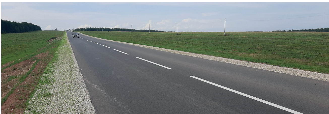
▲ Национальный проект «Безопасные и качественные автомобильные дороги», 2020. Камско-Устьинский муниципальный район, завершён ремонт автомобильной дороги Казань – Ульяновск
