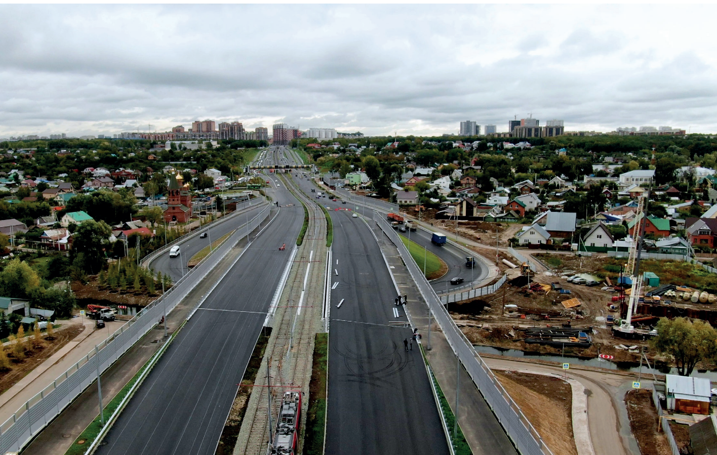
Казанская агломерация, ход строительства второго этапа Большого Казанского Кольца
