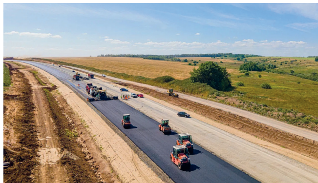
Строительство автомобильной дороги федерального значения М-12
