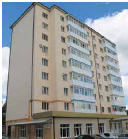
48-квартирный монолитно-каркасный дом введен в эксплуатацию 17.12.2014 г.
