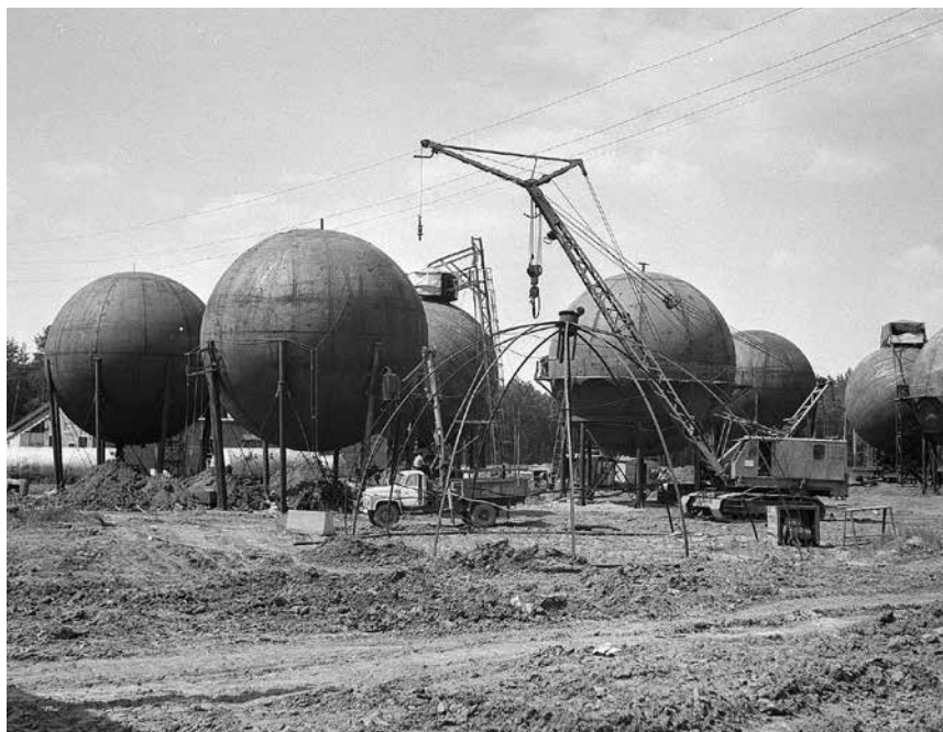
Строительство газгольдеров в Татарии, 1970-е гг.
