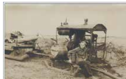
▲ Прокладка трассы Миннибаево – Ижевск
