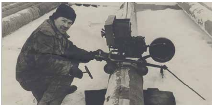
▲ Диагностика швов сварки. Прокладка трассы Миннибаево – Ижевск; Казань – Йошкар-Ола
