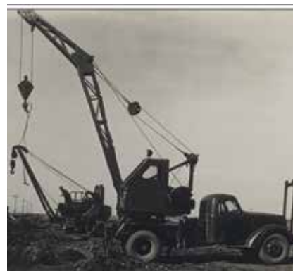
▲ Спецтехника на ремонте ГП
